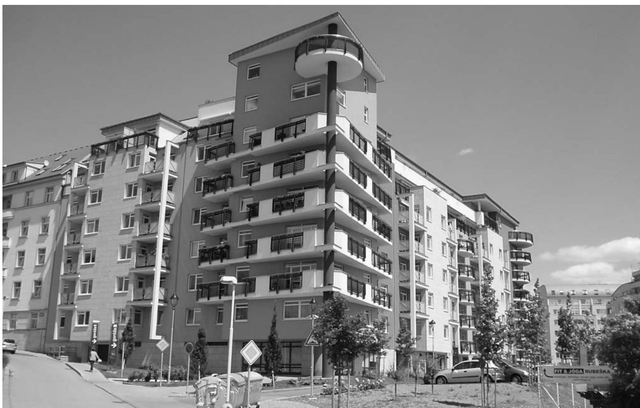
Stavba: Bytový dům Rokytka, Praha
